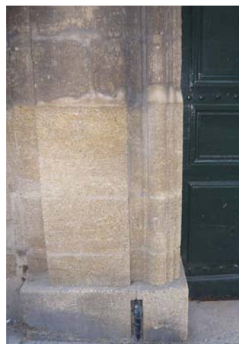
Remplacement de pierre en tiroir et pierre de taille et joints d'une grande finesse à droite.
