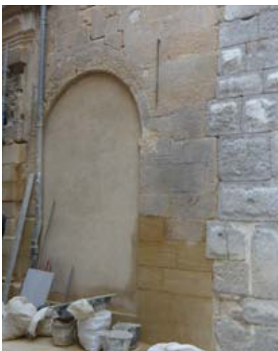
Remplacement de pierre en tiroir et pierre de taille et joints d'une grande finesse à droite.
