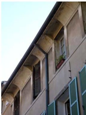
Débords de toiture : de gauche à droite, corniches à gorge en plâtre, corniches moulurées, chevrons débordants ou queues de vaches et génoises. clichés VW
