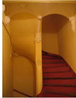
Escalier Renaissance à XVIIe, à retour, ornés de croisées
