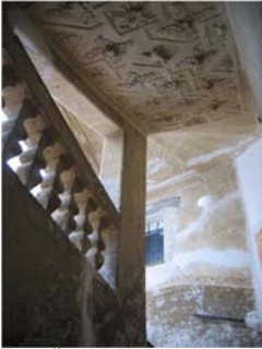
Escalier XVIIe rampe sur rampe. balustrades en pierre et décor de gypseries
