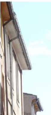
Débords de toiture : de gauche à droite, corniches à gorge en plâtre, corniches moulurées, chevrons débordants ou queues de vaches et génoises. clichés VW
