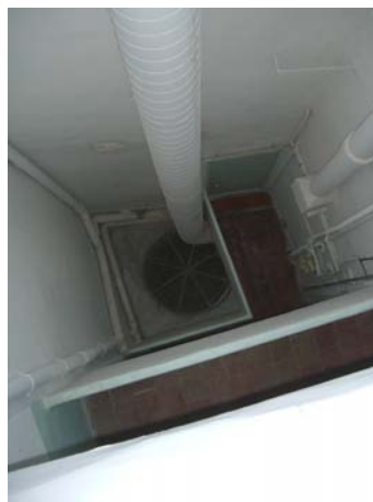
Puits de lumière occupé une gaine d'extraction.
