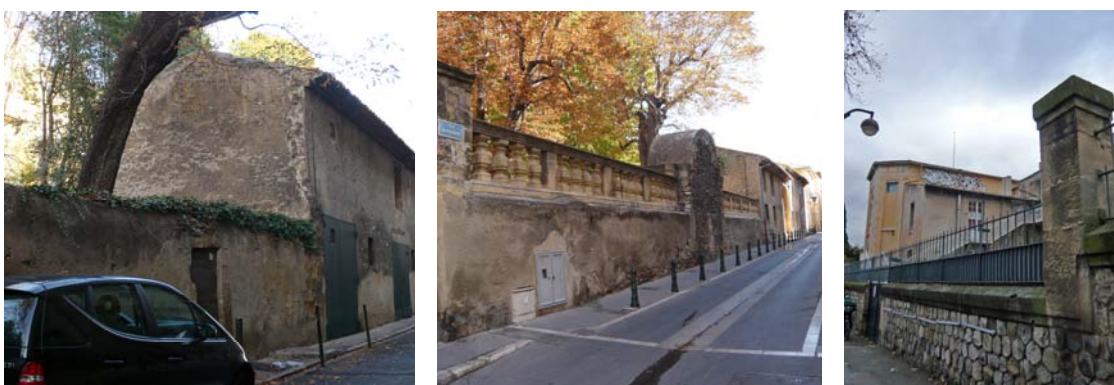
Photographies du quartier Mazarin, les murs de clôtures sont surmontés d'un glacis, de balustres ou de grilles avec pierre de couronnement, cliché V.W.
