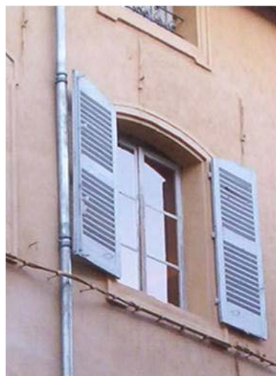
14 rue du Quatre-Septembre. Baie cintrée. menuiseries de type XIXe, grands carreaux tiercés.
