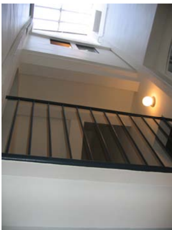
Palier de distribution privatisé au dernier niveau.
