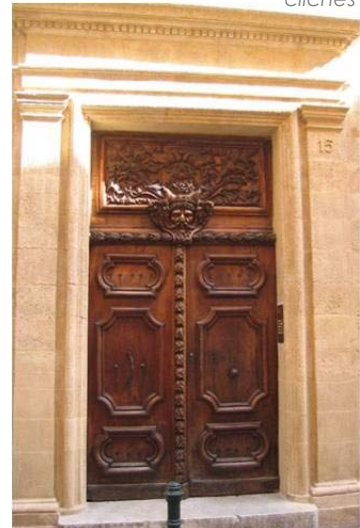
Hôtel de Combes, 15 rue des Epineaux, porte XVIIe siècle, à fortes moulurations, guirlandes, mascarons à la base de l'imposte et décor végétal.
