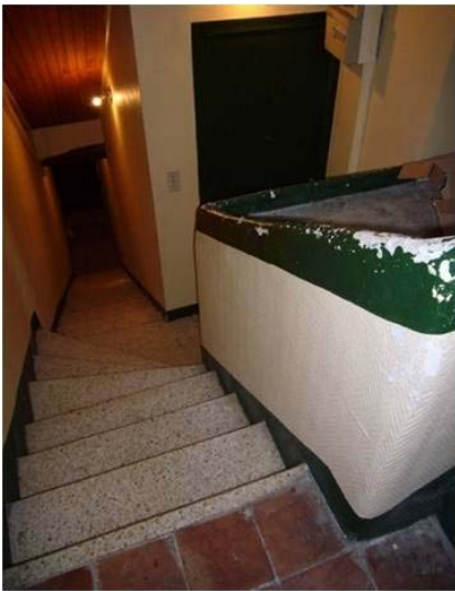
Escalier droit XXe jusqu'au 1 er niveau, escalier XVIIIe dans les étages.
