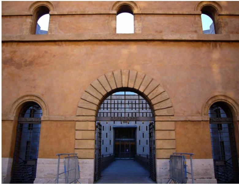
L'intérieur de l'ancienne prison a été repensé, l'enveloppe protégée au titre des Monuments Historiques est conservée, elle accueille une expression nouvelle. (architectes : J-M. Battesti et J-L. Roubert)
