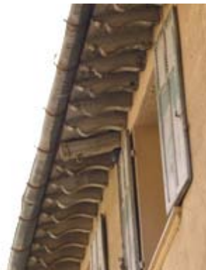
Débords de toiture : de gauche à droite, corniches à gorge en plâtre, corniches moulurées, chevrons débordants ou queues de vaches et génoises. clichés VW
