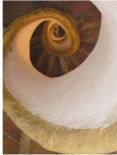
Escalier médiéval en vis à noyau creux
