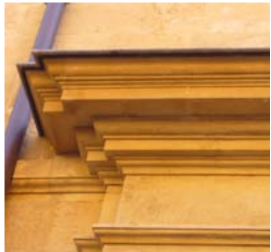
Ci-dessus exemples de couvertines plomb et zinc sur partie saillante, cliché VW.
