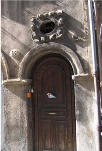
28 rue de Brueys Porte Renaissance en arc plein cintre, moulurée, surmontée d'un oculus
