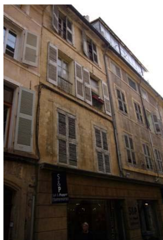
3 bis rue Mathéron la façade commerciale est aménagée sur deux parcelles, elle ne respecte pas la trame.
