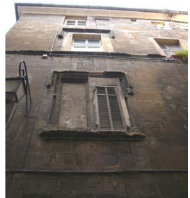
Hôtel de Périer, fenêtres à meneaux remaniés, rue Rifle-Rafle, cliché S.J.
