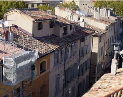
Toitures à une pente ou deux pentes, sur rue et surcroîts en retrait.
