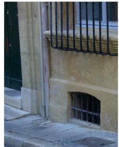
Ventilations de la cave au niveau de la voie, 29 rue de l'opéra cliché GF
