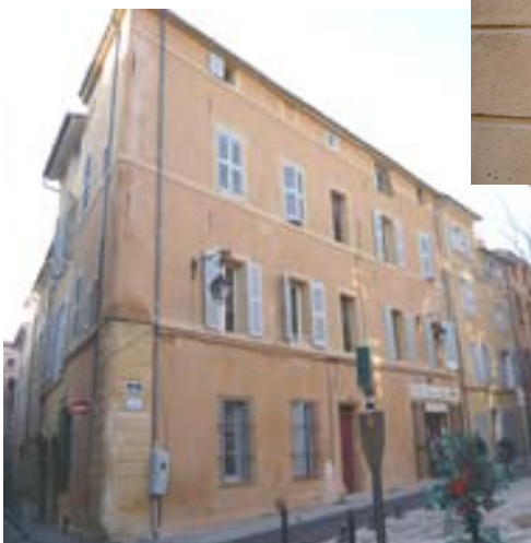
Cordons filants et encadrement de baies moulurés en enduit.
