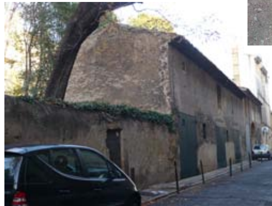
Pignon traité avec un enduit ancien : chaux et sable de rivière
