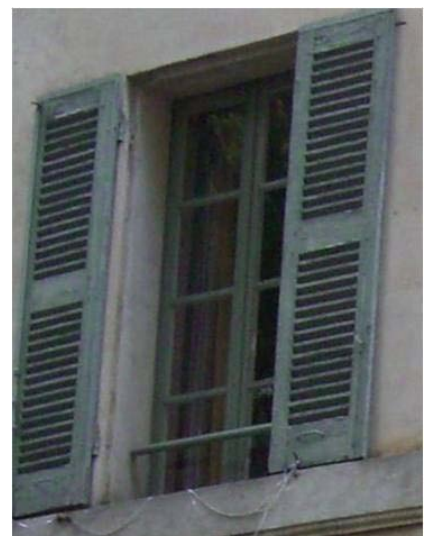
2 rue Manuel, baie à linteau droit XIXe menuiseries à grands carreaux.
