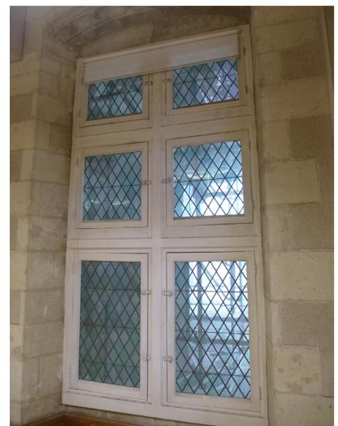
Relevé et détail de fenêtre d'imposte à panneaux vitrés sertis en plomb. Remplacement des panneaux vitrés par des carreaux, rue St-Vincent.
