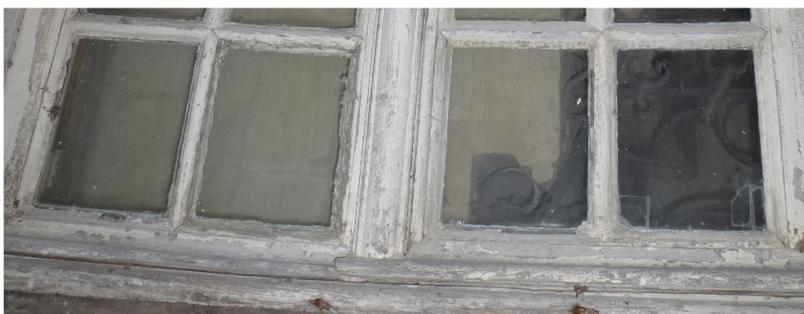
Relevé d'une fenêtre à croisée et petits carreaux déposée dans les locaux de Nantes Renaissance ; détail des carreaux collés.
