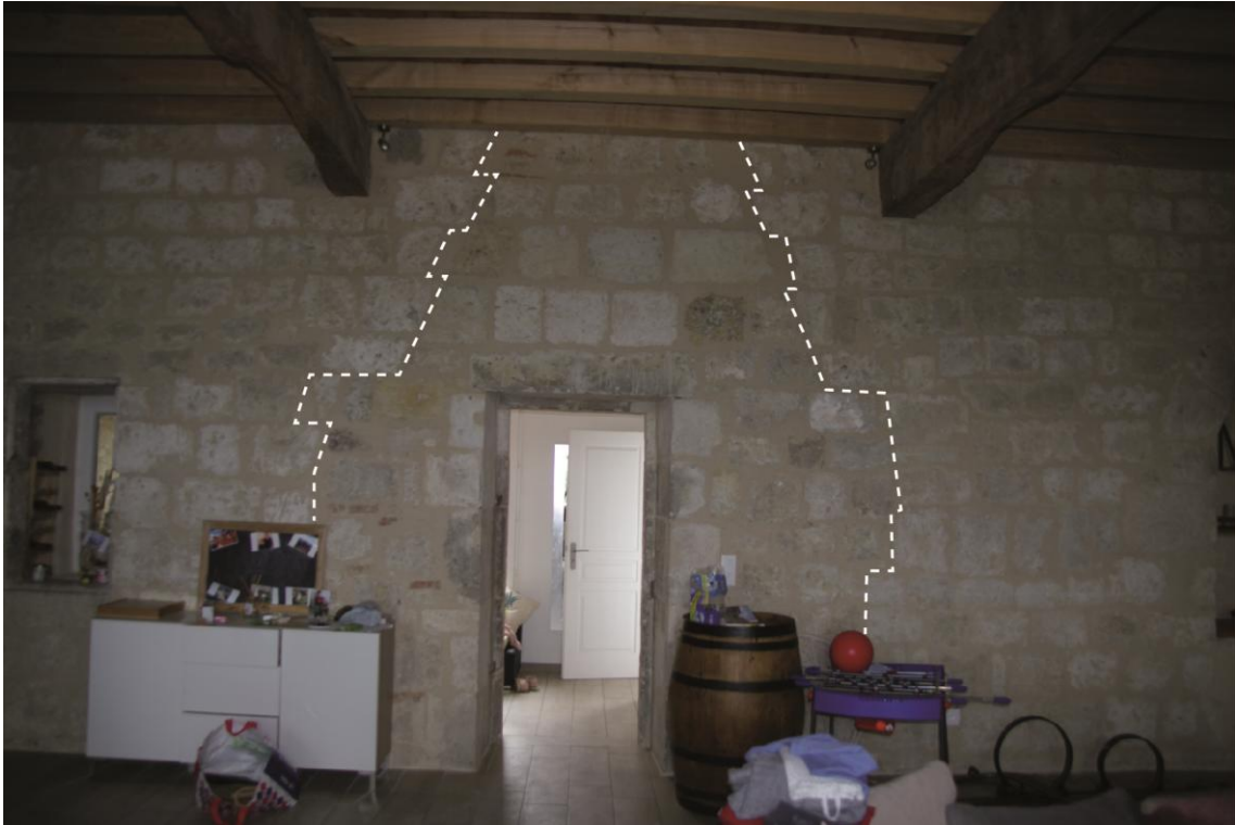
Fig. 10 – Négatif de cheminée monumentale au deuxième étage d'une maison (CK0278) Cliché de J. FOLTRAN, Hadès, 2021
