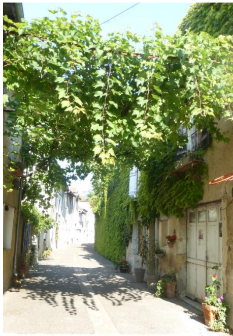
Végétation en débord sur l'espace public
