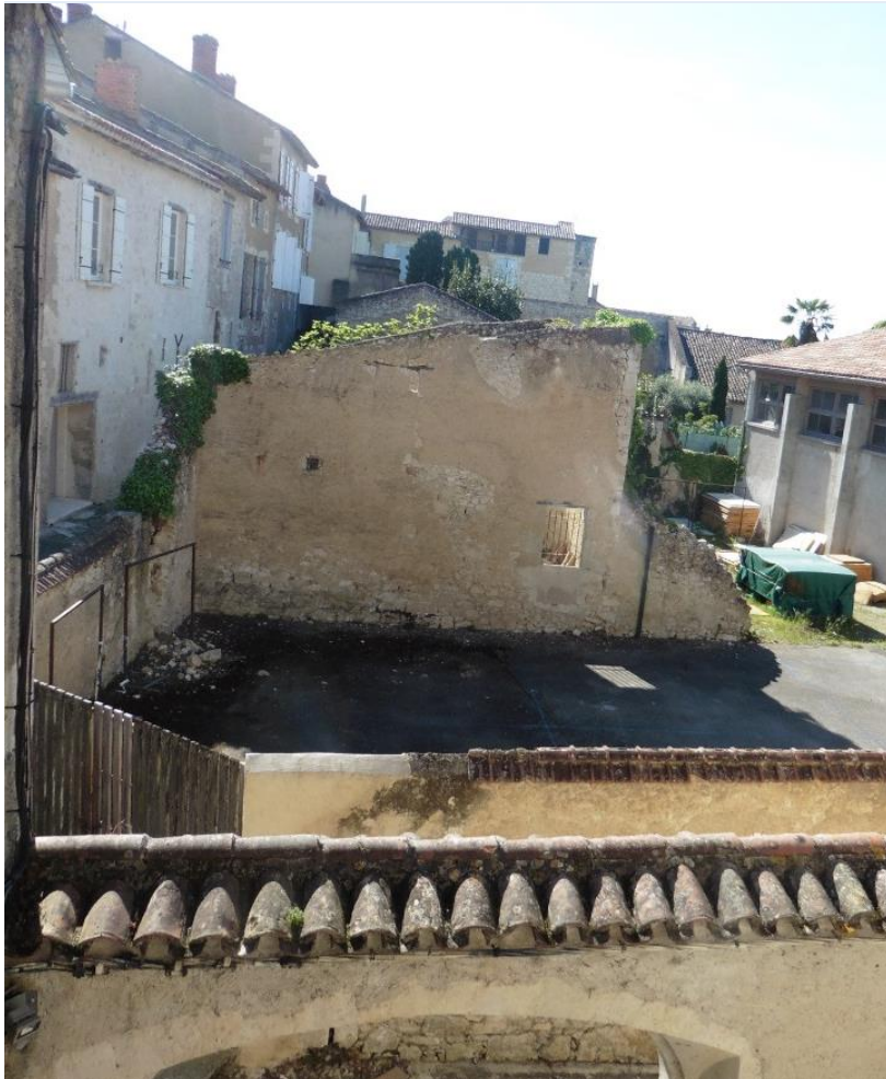
Exemple d'espace non bâti à requalifier
