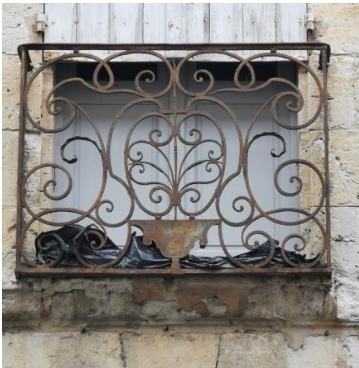
Garde-corps ouvragé en fer forgé sur balconnet (XVIIIe s.)
