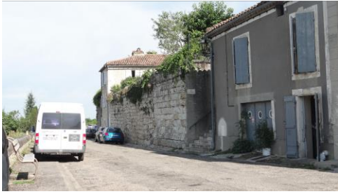
Boulevard Jean Jaurès: alternance des maisons et des soutènements de jardins
