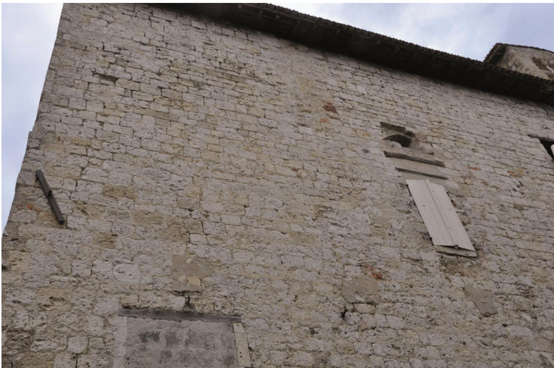
Fig. 3 – Parement présentant un moyen appareil de type B (CK0704) Cliché de J. FOLTRAN, Hadès, 2020
