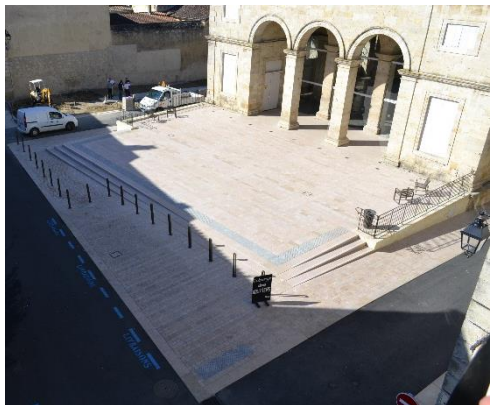
Aménagement de la place Seguin et mise en accessibilité de la Halle. 2017
