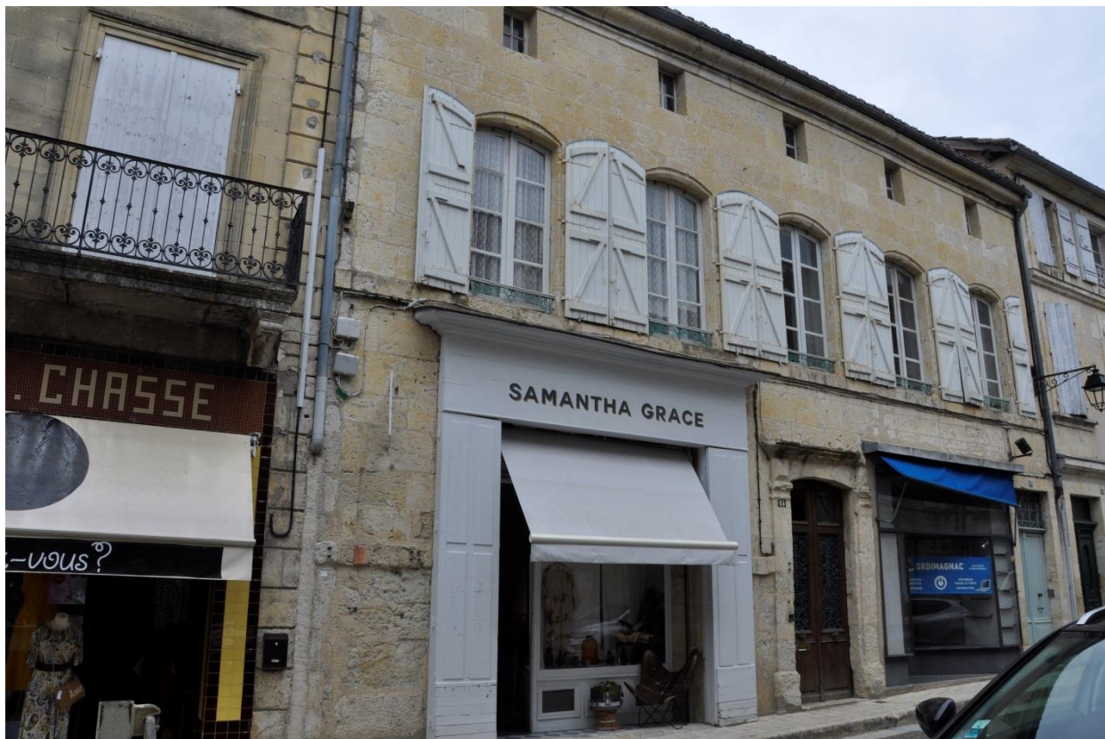
84 rue Nationale : le premier étage de la façade du XVIII e siècle est rythmée par les fenêtres et les volets.
