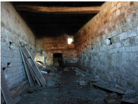
Rez-de-chaussée d'un bâtiment médiéval
