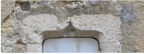
Linteau en accolade
