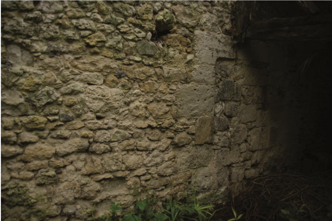
Fig. 4 – Parement présentant un appareil peu soigné du XV e -XVI e siècle (CK0279) Cliché de J. FOLTRAN, Hadès, 2021
