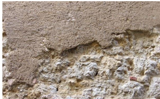
Enduit extérieur à base de chaux et cailloutis fin sur moellons
