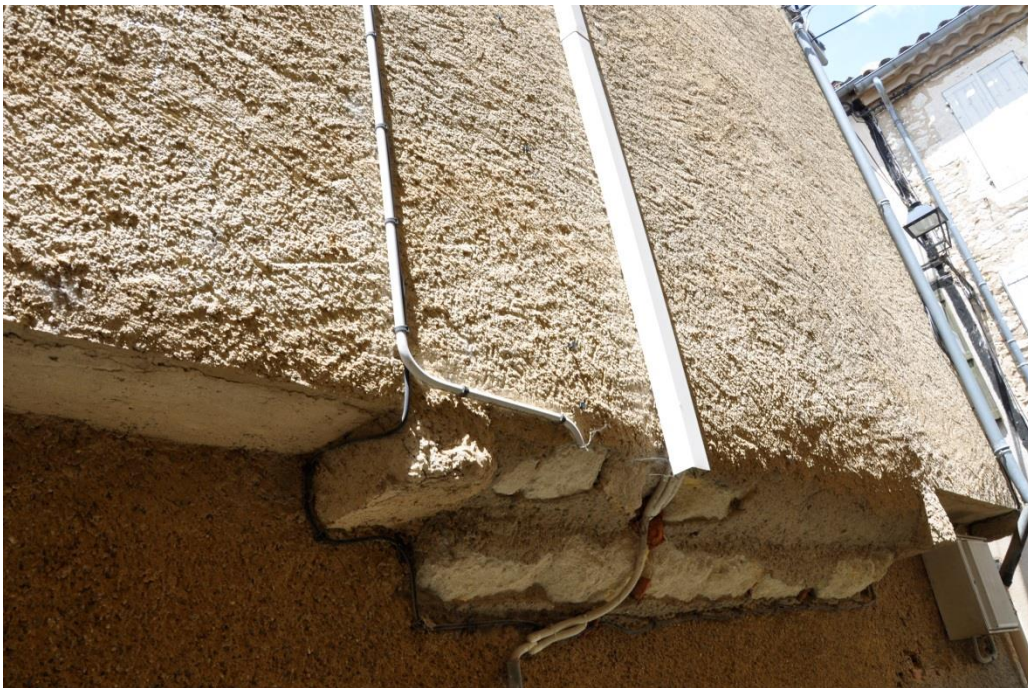
33 rue Antichan : support de cheminée en encorbellement
