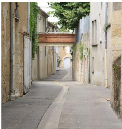
Les dispositifs de collecte des eaux pluviales en surface dans les rues.
