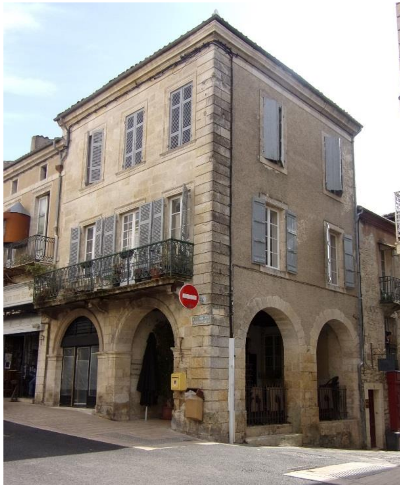
Bâti sur la rue Nationale présentant une façade principale avec parement en pierre de taille et une façade secondaire sur rue enduite.
