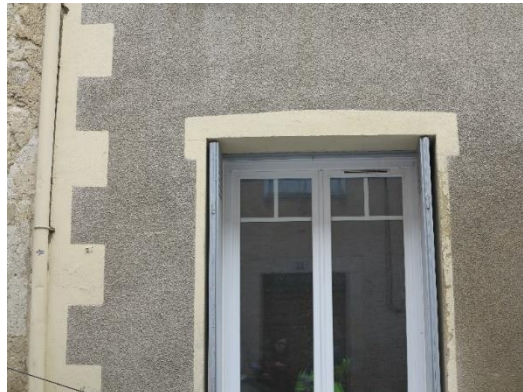
Les décors en façade : enduits à grain, fausse coupe de pierre
