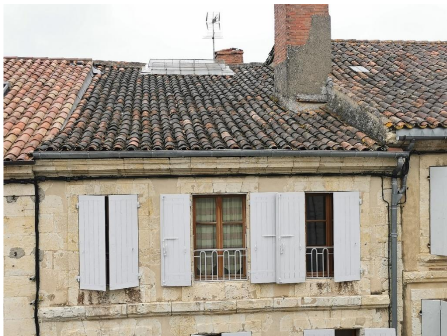
Couverture en tuile canal avec verrière pour éclairer la cage d'escalier.
