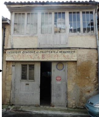
Immeuble bâti D atelier en fond parcelle
