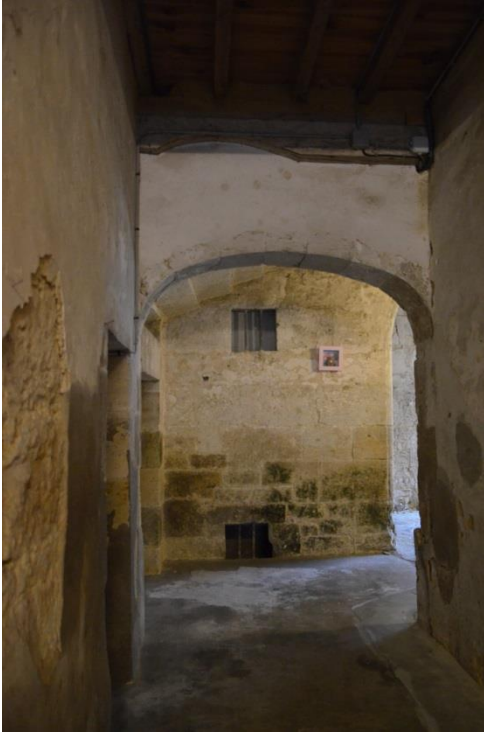
Le mur d'échiffre de l'escalier se dresse au bout du couloir
