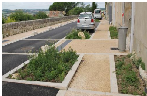
Quelques jardinières publiques au sol entre les places de stationnement le long de la chaussée
