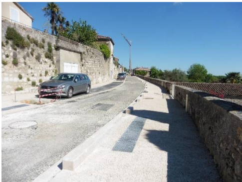
Boulevard du midi, travaux en 2019
