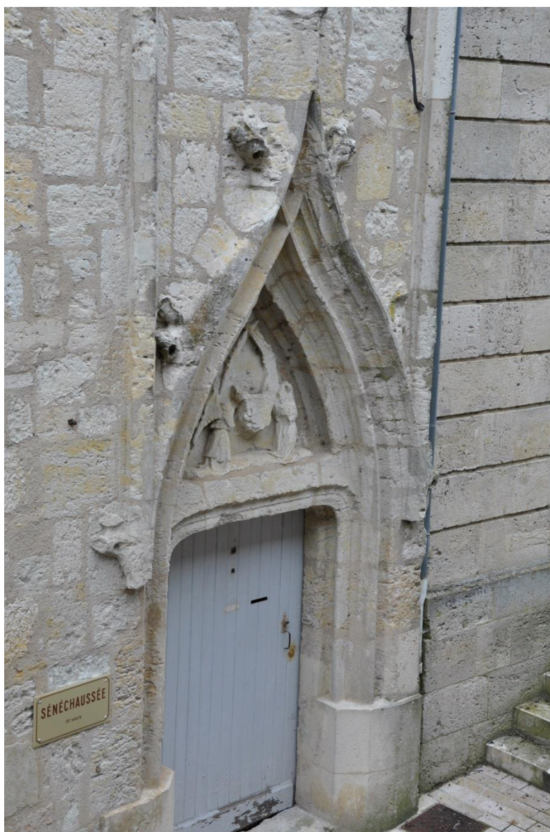
Ancienne sénéchaussée, 4 rue Montebello
