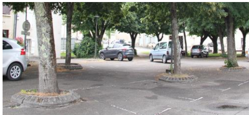
Imperméabilisation systématique des sols, la végétation dispose de très peu d'espace (bordures routières autour, grilles au sol...)- source: Eugée
