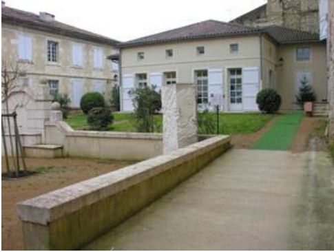
Médiathèque-ludothèque de Lectoure
