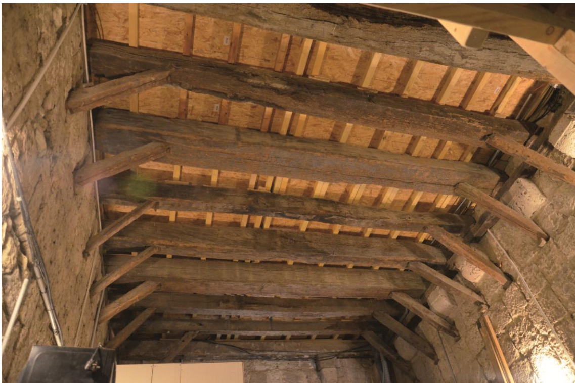
Fig. 5 – Solives couvrant le rez-de-chaussée d'une maison (CK0774) Cliché de J. FOLTRAN, Hadès, 2021
