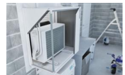
Mise en œuvre unité extérieure (UE) de PAC côté intérieur
