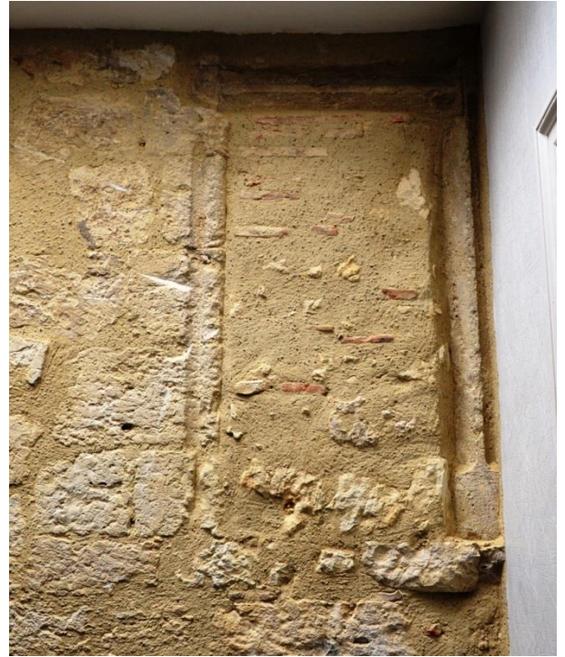
12 rue Fontelie : croisée bouchée ayant conservé son meneau et un croisillon chanfreinés
