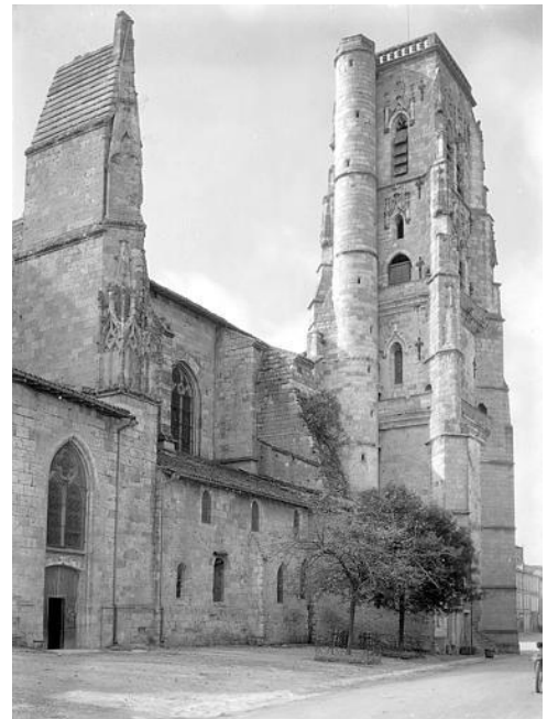
Eglise Saint-Gervais – source: Atlas des Patrimoines
