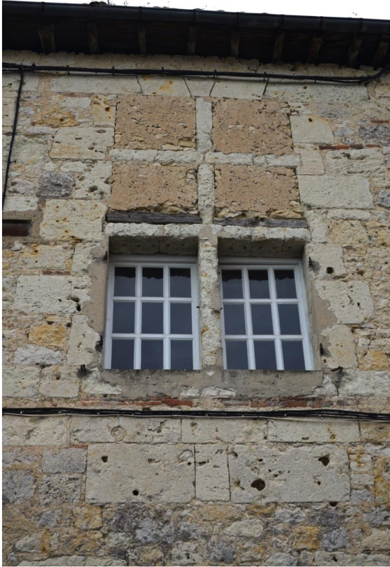
25 rue Jules de Sardac, maison Roquelaure : grande croisée dont les quatre panneaux supérieurs ont été bouchés.
