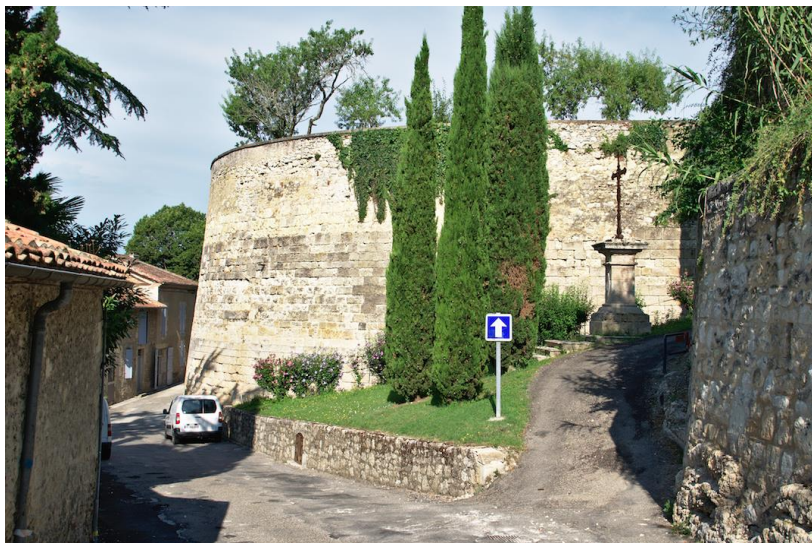
Articulation entre le bastion et le rempart, relations entre bâti plus ou moins modeste et élévation des fortifications.
