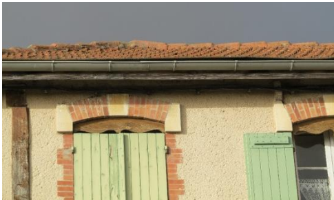
Maison du début de XXe siècle avec couverture d'origine en tuiles de Marseille
