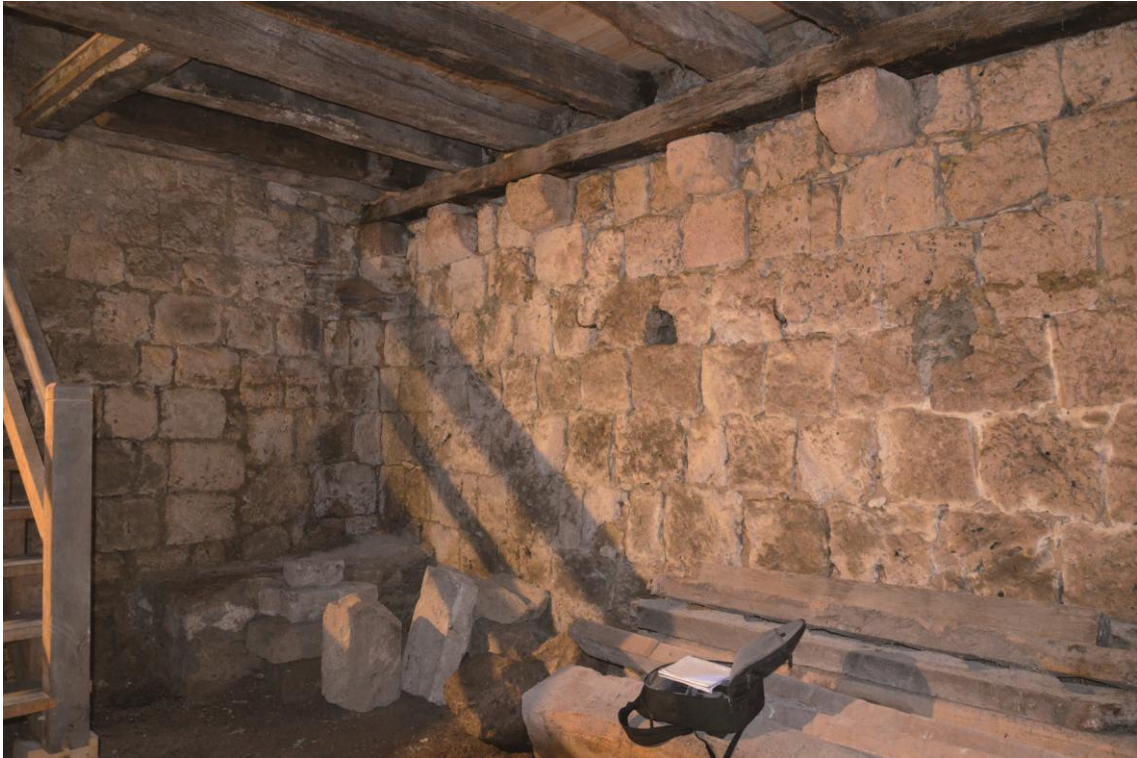
Fig. 2 – Parement présentant un moyen à grand appareil de type A (CK0116) Cliché de J. FOLTRAN, Hadès, 2020
