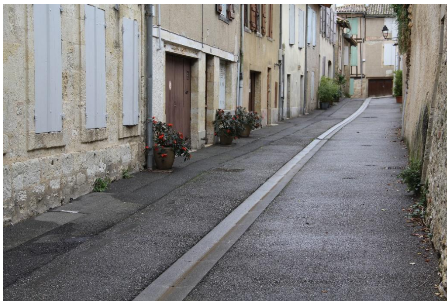
Aménagement de voirie pour la collecte des eaux pluviales
