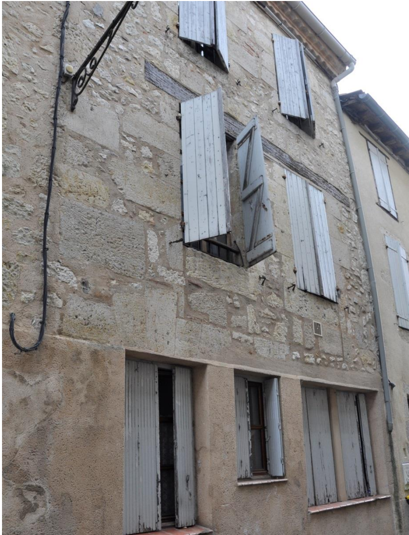
30 rue Antichan : 1787 (rez-de-chaussée repris en sous-œuvre)
