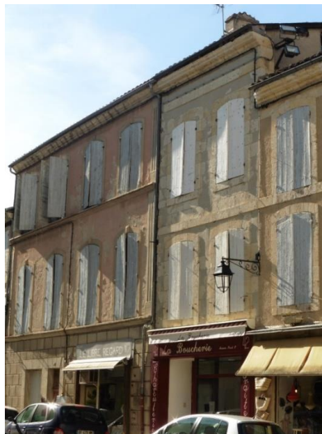
Façade principale, l'enduit couvrant est lisse, il peut recevoir un badigeon coloré
