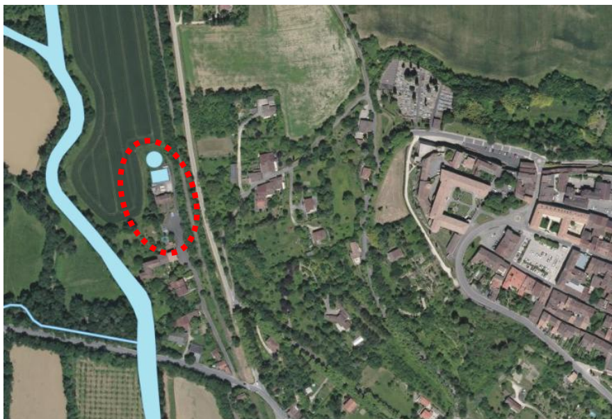
La station d'épuration de Lectoure
