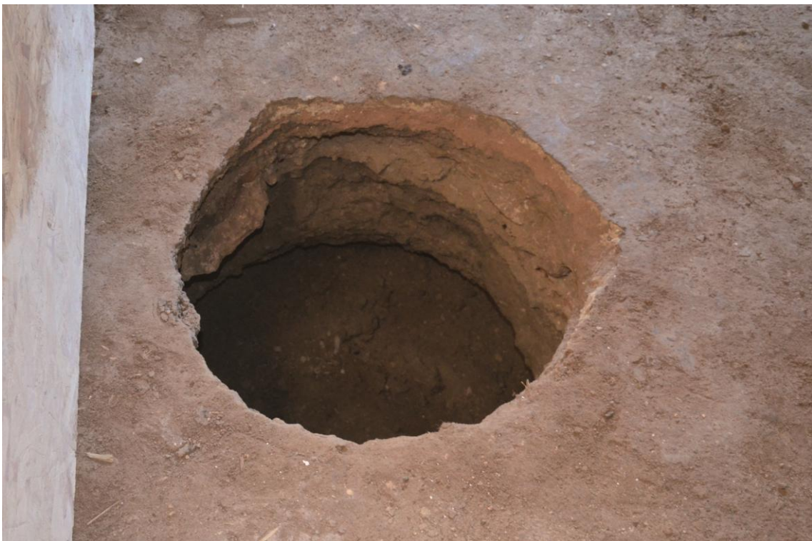
Fig. 9 – Ouverture d'une fosse-silo en rez-de-chaussée (CK0116) Cliché de J. FOLTRAN, Hadès, 2021
