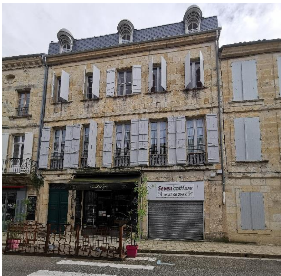
Toit à la mansard XIXe, brisis ouvert en ardoise et éclairé par des lucarnes « guitare ou guitarde ».
