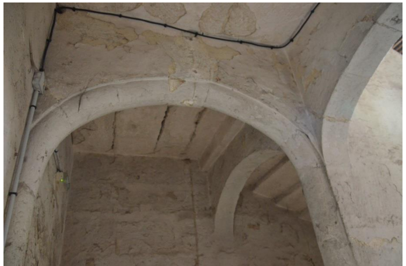
Arcs soutenant l'escalier au niveau d'un repos
