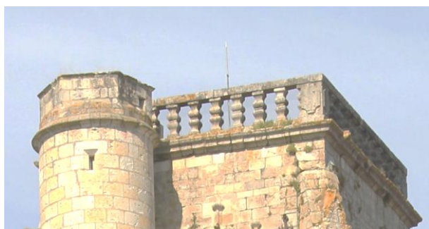
Antennes (réseau mobile) situées dans le clocher de la cathédrale
