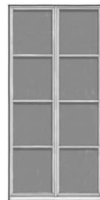
Fenêtres XIXe et XXe siècle : le verre s'affine et la fenêtre s'agrandit, l'étanchéité se perfectionne. Généralisation de la crémone comme système de fermeture.
