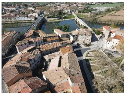
Le pont Neuf (1846) à aval du pont Vieux
