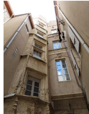
4, rue de l'Argenterie. Tour d'escalier sur cour intérieure
