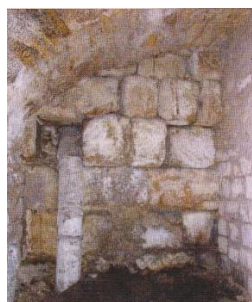
Maison Bousquet, 57, place des Bons Amis. Mur avec blocs antique de remploi. Cl. C. Olive)
