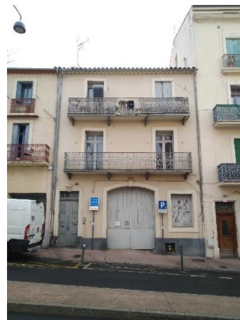
49, avenue Gambetta. Petit immeuble. Porte cochère au rez-de-chaussée.
