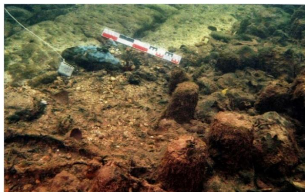
Maçonnerie au pied d'une arche du Pont Vieux. Cl. IBIS, dans Olive, Ugolini 2012, p. 147)
