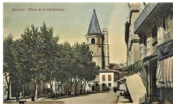
La place de la Madeleine. Carte postale, vers 1910. La démolition des bâtiments adossés au chevet de l'église a permis la mise en valeur de l'édifice exposé sur une place plantée d'arbres.
