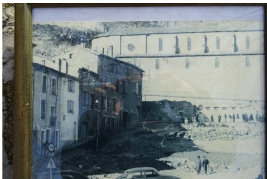
Vue du faubourg Saint-Jude. Démolition en cours. Photo privée
