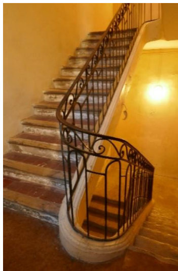
57, place des Bons Amis. Hôtel du XVIII e siècle. Escalier suspendu et rampe en motif d'arcade.
