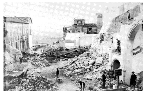
Travaux de démolition de l'église du Collège (1902) (musée du Biterrois, dans Lapeyre, Roque 1984)
