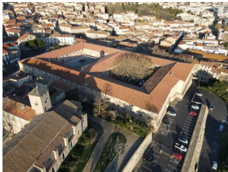
Tracé présumé de l'enceinte au pied des casernes et tronçon du jardin de l'église Saint-Jacques
