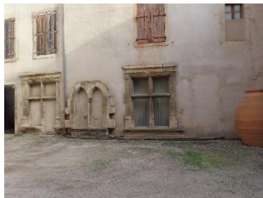
19, rue Française. Hôtel Bonnet de Maureilhan. Fenêtres à meneau de la façade sur cour
