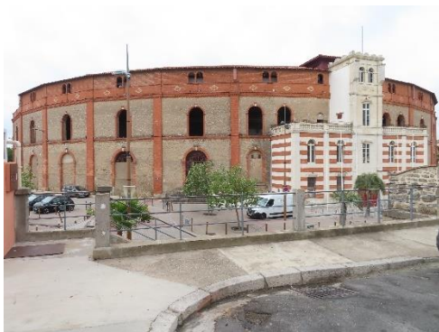
Les arènes, 1897-1901. Léopold Carlier, architecte
