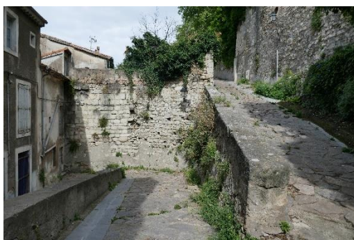
Tronçon supposé sur la rampe Canterellette
