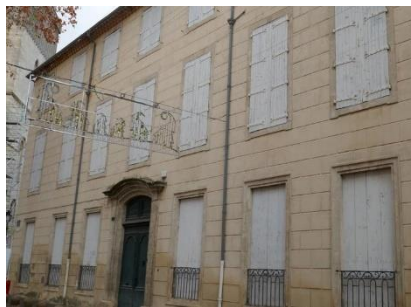
4, place de la Révolution. Le traitement du parement en fausse coupe de pierre est un ajout réalisé à l'enduit
