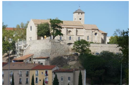
Tronçon sud-est : muraille et bastion
