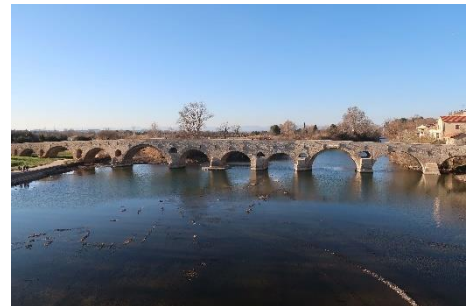
Le Pont Vieux.
