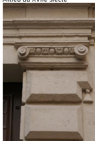
4, rue Fabrégat. Portail. Piédroit en bossage, chapiteau ionique et motif de goutte.
