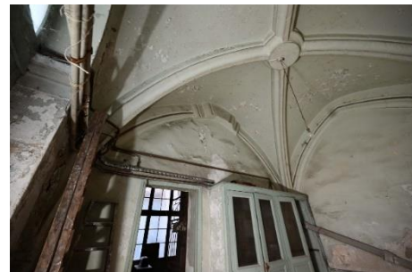
Hôtel Cabrerolles de Vallat de Lespignan. 3, rue de Bonsi. Au rez-de-chaussée, deux pièces voûtées sur croisée d'ogives appartiennent à l'ancien couvent des Dominicains.
