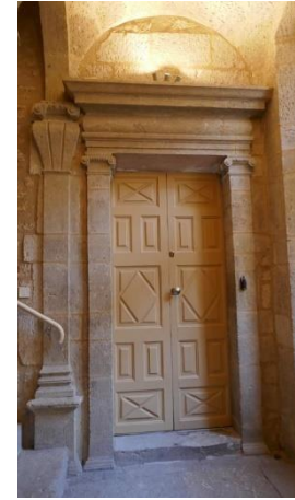
Palier sous coupole et porte palière de l'hôtel d'Arnoye, place Lavabre. Dernier quart du XVI e siècle
