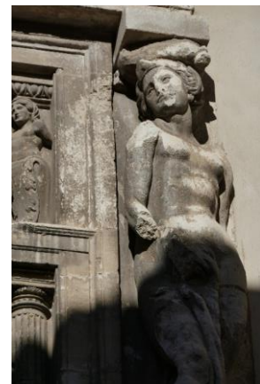
14, rue du Puits des Arènes. Hôtel de la Mercy. Fenêtre Renaissance. Caryatide
