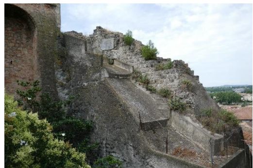
Tronçon boulevard Jean Macé/rue Canterelles
