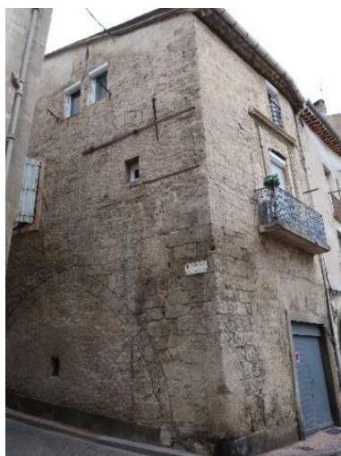
Maison du XIIe siècle. 7, rue du Puits des Arènes. Grand arc brisé et fenêtre géminée.
