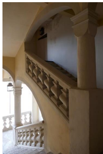
23, rue des Balances. Hôtel Sarret de Coussergues. Escalier rampe sur rampe. Milieu du XVIIe siècle
