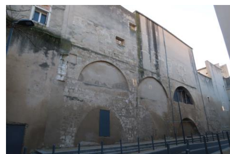
Rue Maître Gervais. Façade arrière de maisons romanes détruites. Les grands arcs de décharge superposés appartiennent à un système constructif médiéval.
