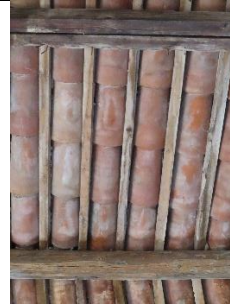
Le graphisme se présente dans le sens de la pente ; la tuile canal s'adapte aux déformations de la charpente
