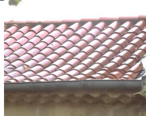
Le graphisme se présente dans le sens de la pente ; la tuile canal s'adapte aux déformations de la charpente
