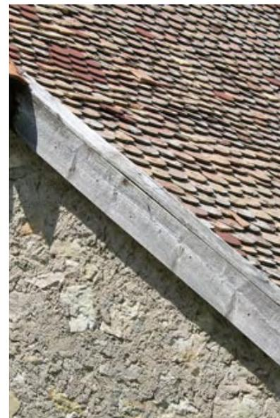
Exemple de rive en planche qui peut également être recouverte de zinc pour la protéger.
