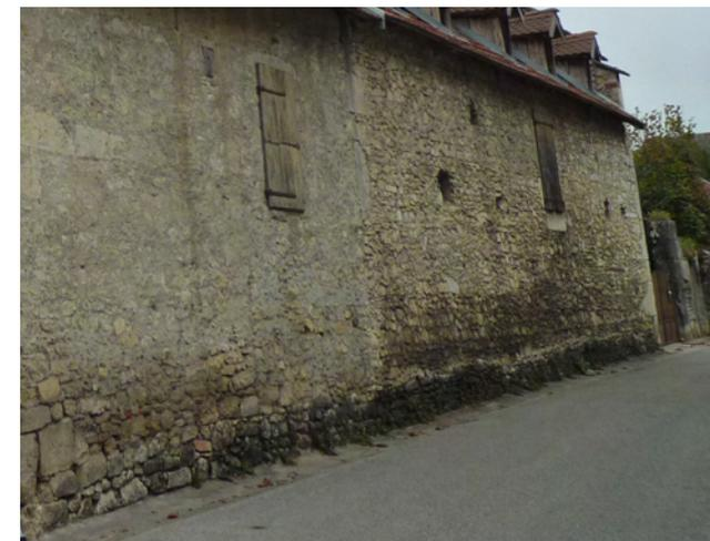
*Exemple de dégradations de la partie basse d'un mur en pierre, dues à des remontées capillaires ou des rejaillissements d'eau qui pourraient être en partie résorbés par la création d'une bande perméable au pied du mur.*
