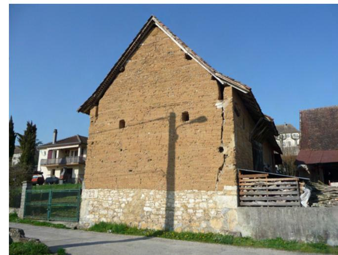
Exemple de grange en pisé (avec son soubassement en moellons de pierre). Le parement sur ce type d'édifice est le plus souvent laissé à l'état brut sans enduit.
