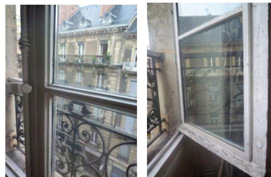
exemple de solution B): Photos d'un double vitrage avec cadre extérieur (vue face extérieure et intérieure)
