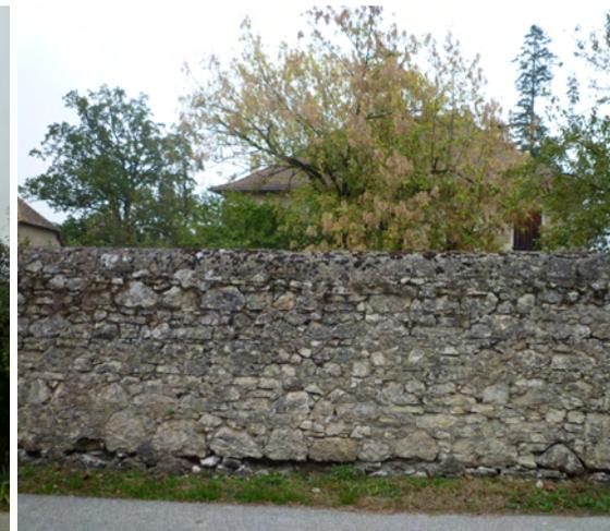
*Les bandes latérales enherbées et les sols perméables permettent une meilleure évaporation de l'humidité au pied des murs anciens en pierre*
