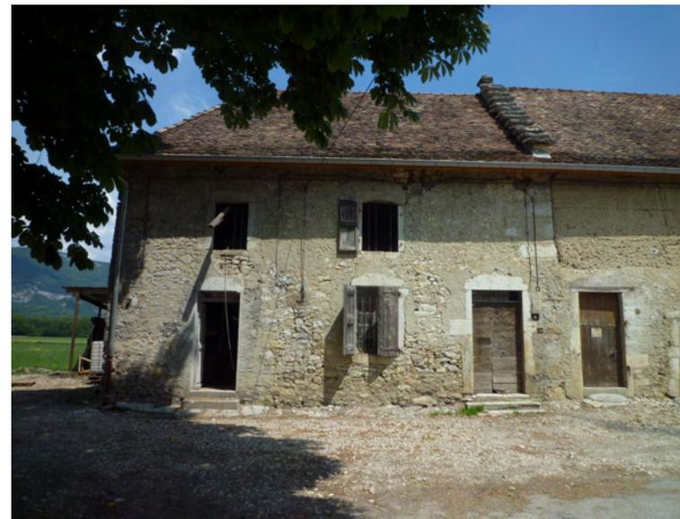
Exemple de construction en moellons de pierre ( parement en moellons de pierre enduit à la chaux, encadrements de baies en pierre)
