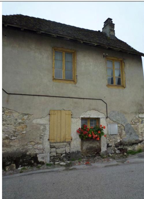
Exemple de construction mixte pierre et pisé (rez-de-chaussée en moellons de pierre, étage en pisé). La façade était entièrement recouverte d'un enduit de chaux dont la partie basse dégradée laisse apparaître la maçonnerie.
