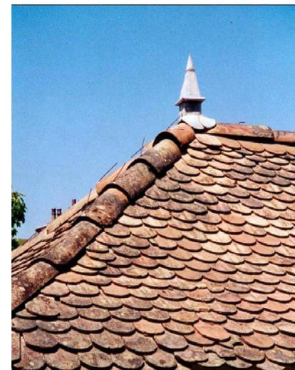
Exemples d'arêtiers en tuiles creuses "tige de botte", tenues par des tiges de fer, adaptées pour les couvertures en tuiles écailles ou en queue de castor
