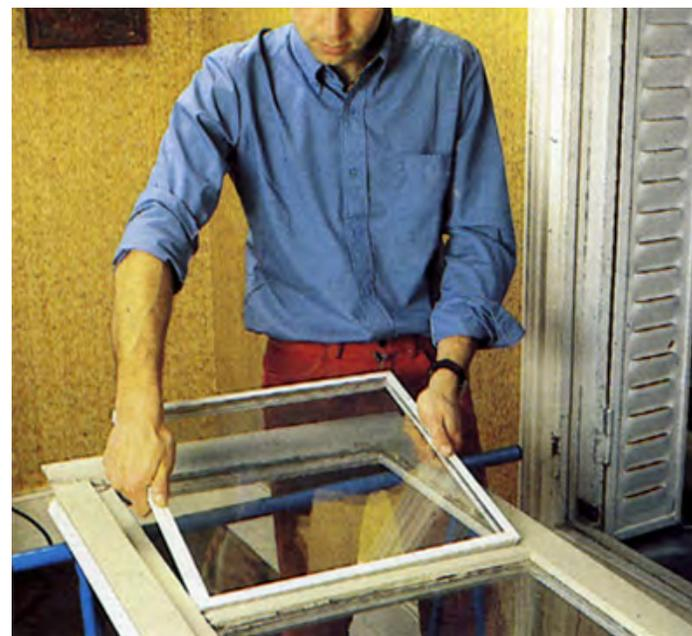
*Pose d'un double-vitrage neuf dans une menuiserie ancienne.*
