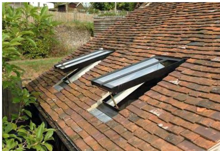
*Exemple de châssis de toit de type patrimoine, inspirés des tabatières anciennes, avec meneau central et encastrés dans la couverture.*
