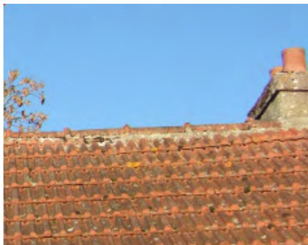
Exemple de faitage en tuiles rondes à emboîtement, adaptées pour les couvertures en tuiles mécaniques à côtes ou losangées.
