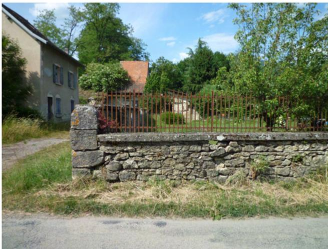
*Mur-bahut en moellons de pierre surmonté d'une grille en fer plat*
