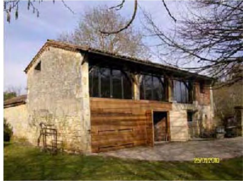
*Le projet respecte la dimension des ouvertures originelles et laisse la structure apparente de manière à rendre bien lisible son ancienne fonction de grange. Les matériaux utilisés sont le bois laissé naturel et le métal pour les baies vitrées.*
