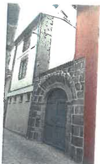
70 rue Chaussade (AX87)
