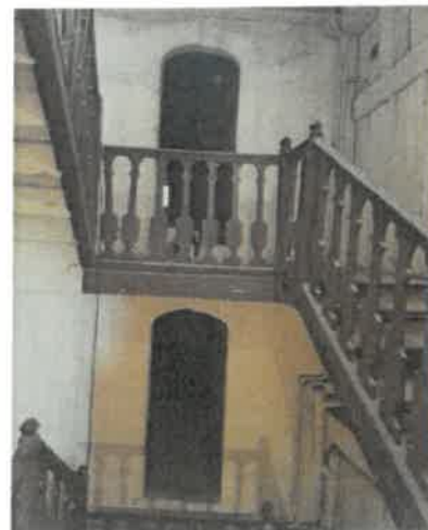
Partie d'immeuble à démolir
