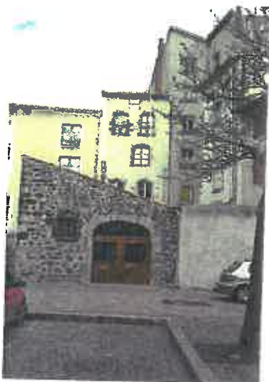
82 rue Chaussade (AX 268)
