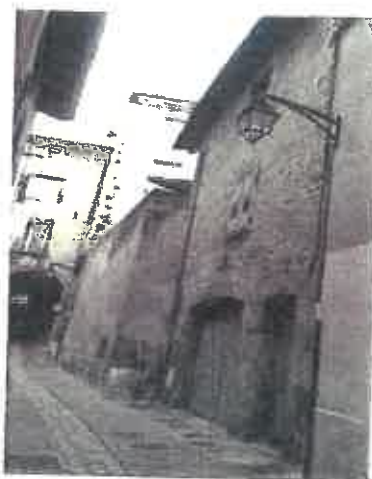
36 rue Chaussade (AX 67)
