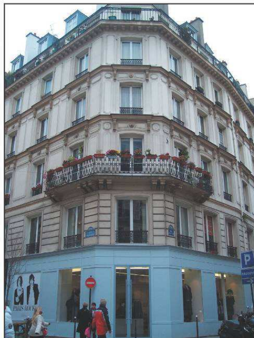
2 bis rue des Rosiers / 13 bis rue Pavée
