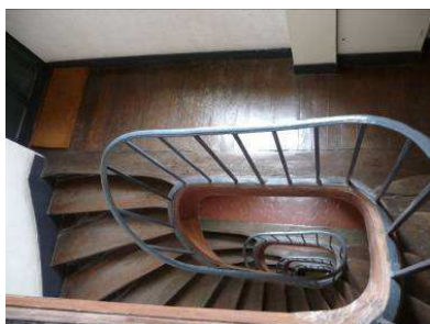
34 rue de Poitou, Escalier à volée à limon suspendu XVIII e siècle
