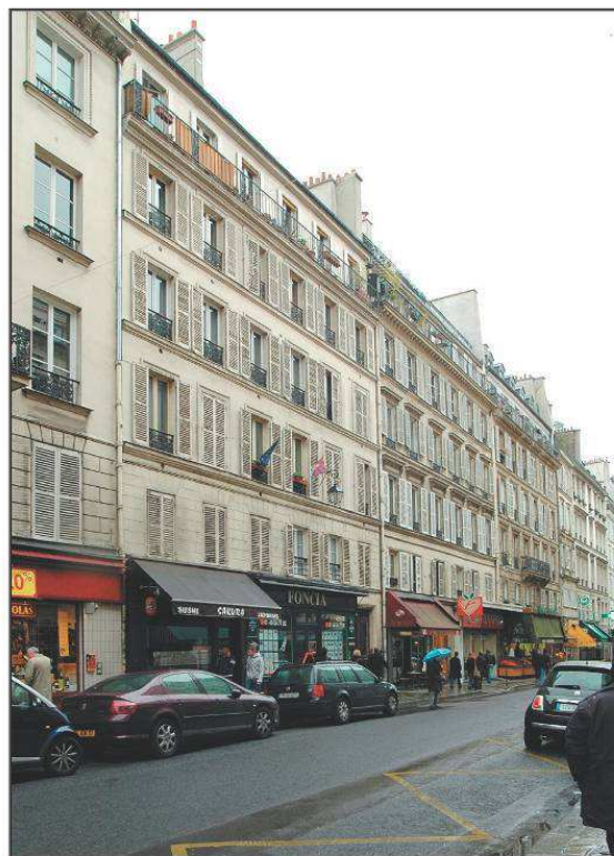
Immeubles des n° 20 à 26 rue Rambuteau
