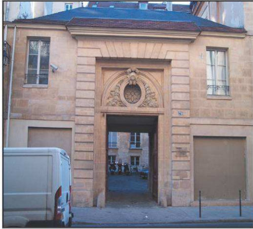
Portail sur rue probablement construit à la fin des années 1650.
