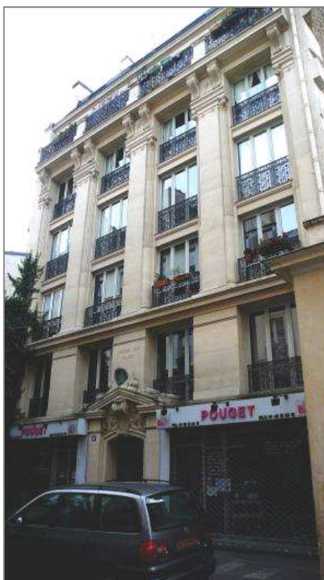
Immeuble-atelier, 15 rue de Montmorency
