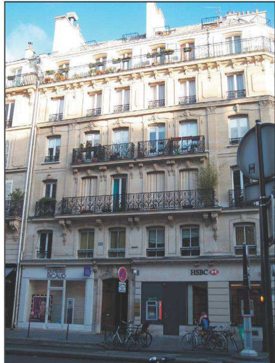
Immeuble 28 rue de Rivoli. Le dessin de cette façade emprunte au style rocaille (mascarons sommant les baies du bel étage, cartouches du deuxième étage). Les quatre travées du milieu mises en valeur par les pilastres embrassant les premier et deuxième étages, allusion aux façades des immeubles des places royales parisiennes dessinées par Jules-Hardouin Mansart.
