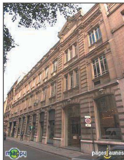
Magasins de la Société des Grands Bazaars Réunis construits à l'emplacement de l'hôtel dans les années 1890.
