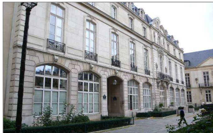
Immeuble 15 rue du Grand Veneur construit en 1866
