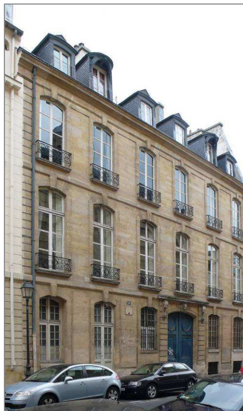
Façade sur rue
