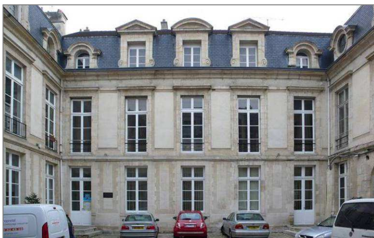
Corps de logis sur cour
