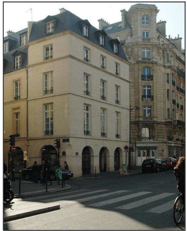
48-52 rue Beaubourg : seule construction ancienne épargnée par l'opération d'élargissement.
