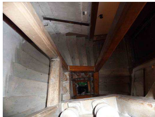
32 rue de Poitou, Escalier XVII e siècle à 4 noyaux
