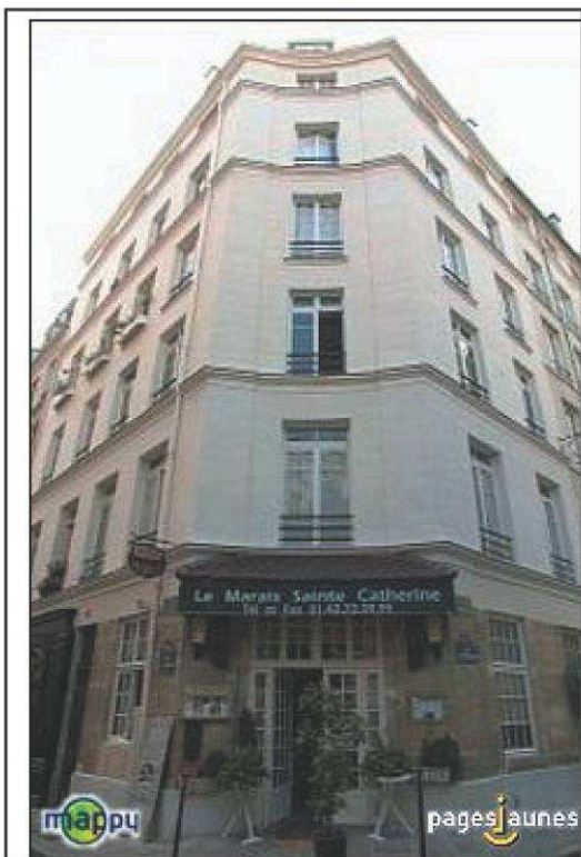
Immeuble du n°7 rue Caron.
