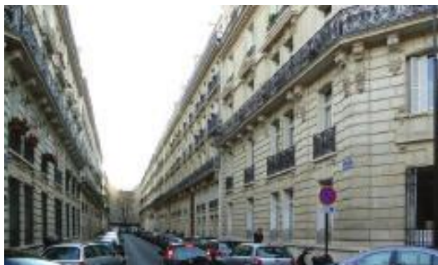
Angle rue de Varenne, cité Vaneau
