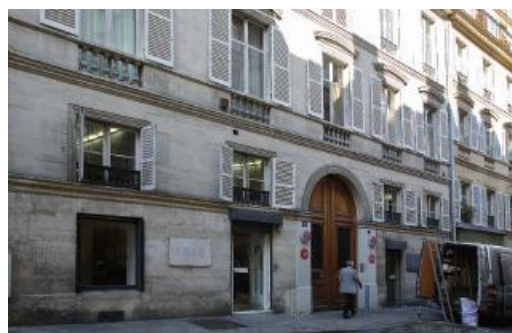
6-8, rue du Pré aux Clercs, deux immeubles construits par Garrez, entrepreneur, décrits dans la Revue Générale de l'Architecture par César Daly.
