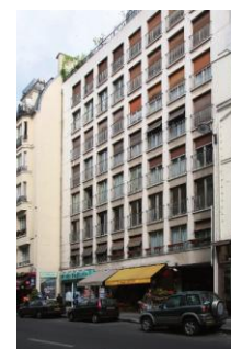
72, rue de Sèvres. Façade sur rue / revers de façade de l'immeuble sur rue / vue de la maison d'habitation construite à la fin du XIX e siècle
