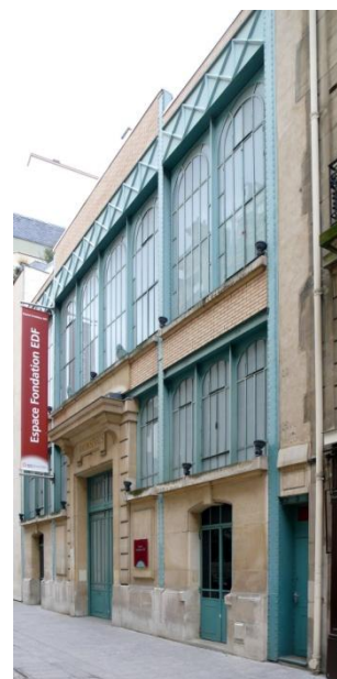
n°7 rue Récamier Sous-station électrique
