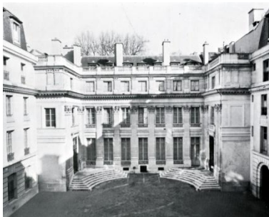
Hôtel de Rochechouart, 110 rue de Grenelle Façade sur cour – Mathurin Cherpitel, Architecte, vue contemporaine
