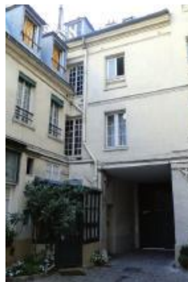
Bâtiment sur rue du début du 18 e siècle.
