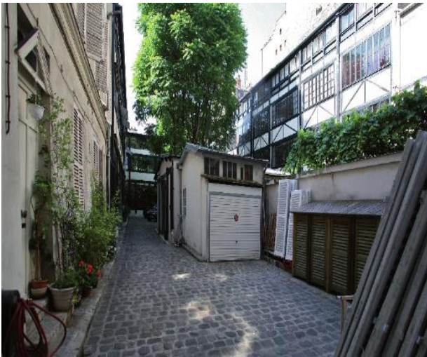
45, rue de Babylone, vue sur les deux parcelles depuis la cour
