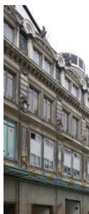
Détail de la façade sur la rue de Babylone
