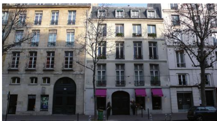
Ci-contre, des façades des 17e et 18e siècles à peine modifiées au 208 et 206, boulevard Saint-Germain
