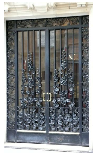
Angle rue Se Simon, rue de Grenelle, détail
