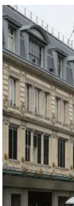
Détail de la façade sur la rue Velpeau
