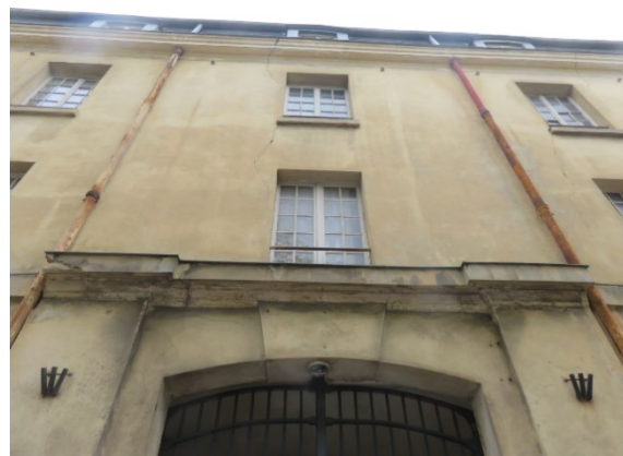
Partie de bandeau subsistant au niveau du portail central, avenue de Sceau
