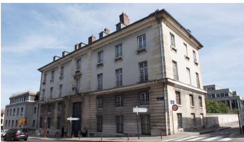
Vue depuis le sud – ouest du bâtiment de la caserne Denfert, classé MH, depuis l'angle des rues Mal. Joffre, monseigneur Gibier.
