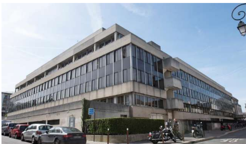
Vue depuis le sud-est, du lycée de 1982, depuis le carrefour des rues Saint Honoré et Albert Samin.
