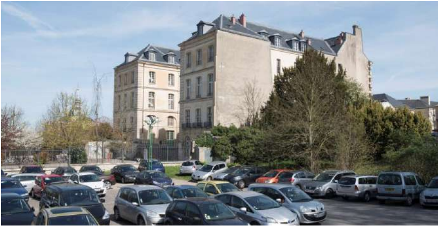
Vue depuis le nord ouest de la parcelle sur les pignons nord de l'hôtel Letellier et le parking actuel au premier plan.
