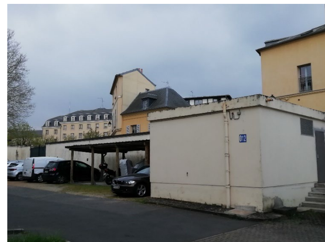
Courette comprise entre la façade sud du bâtiment Carré et le mur de clôture parallèle à la rue Saint Médéric
