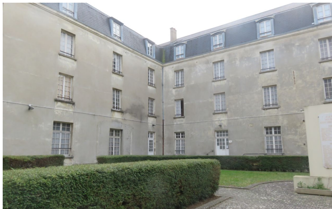
Façades intérieures du pavillon carré et le monument aux morts
