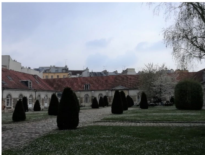
Bâtiments de la cour de l'abreuvoir Ouest
