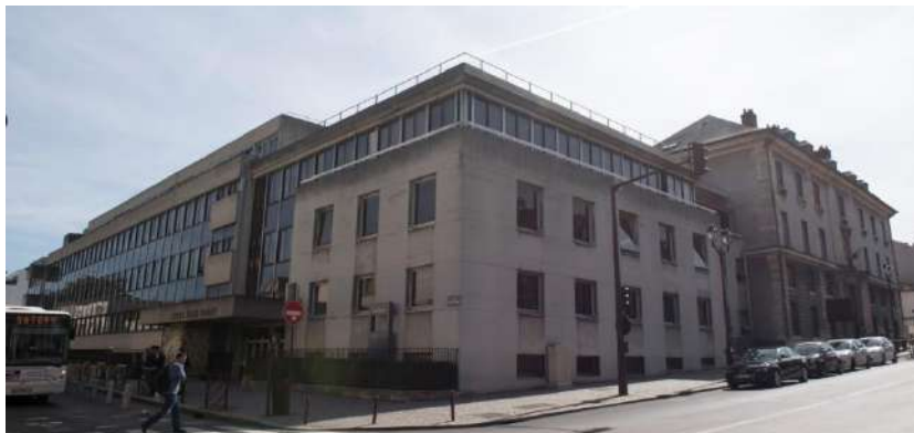
Vue depuis le sud – est de la rue du Mal Joffre des façades du lycée de 1982, à l'angle des rues du Mal Joffre et Albert Samin.
