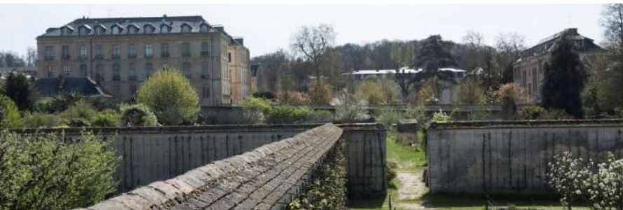
Vue depuis le sud-ouest de la rue du potager du Roi, de la façade latérale nord de l'hôtel Letellier.
