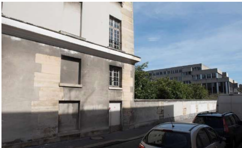
Vue depuis le sud – est de la rue Monseigneur Gibier du pignon du bâtiment de la caserne Denfert classé Monument Historique.
