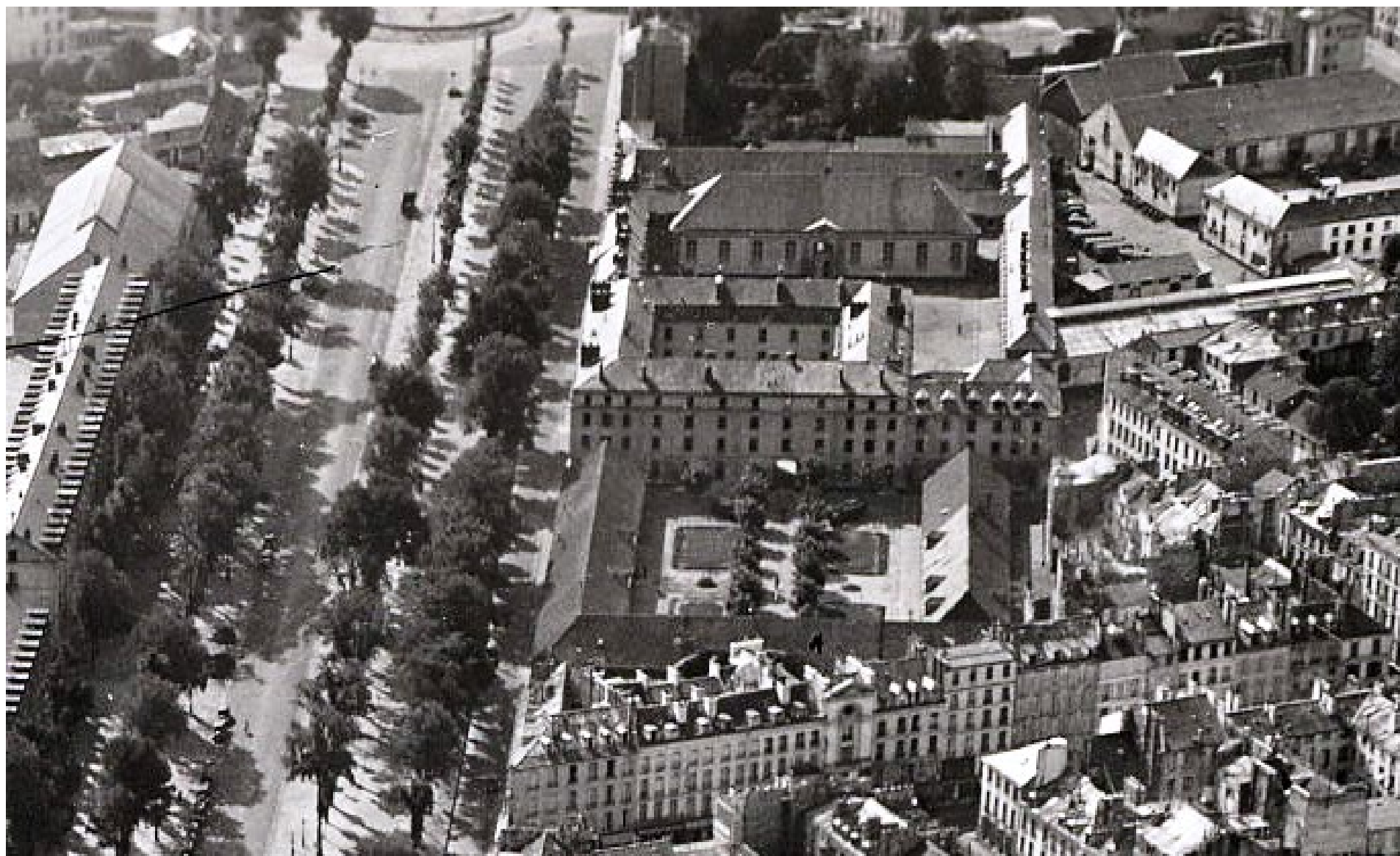
Campagne de photographies aériennes de 1936 - Source Archives communales
