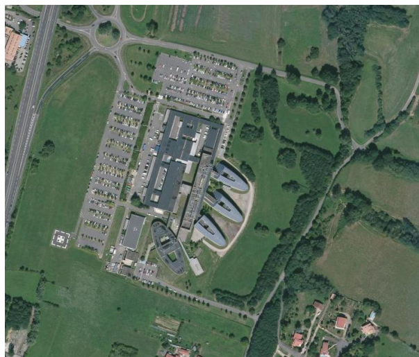
Le CHIVA, équipement structurant sur la commune de Saint Jean de Verges
