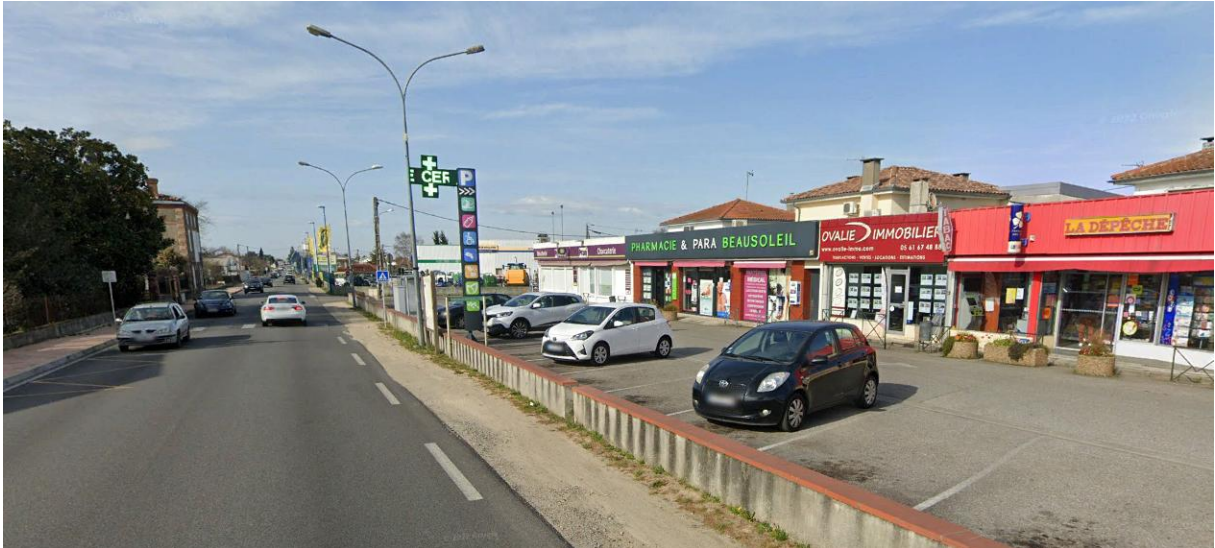
Espace intermédiaire organisé le long d'une traverse d'agglomération, à Saint Jean du Falga, en secteur urbain
