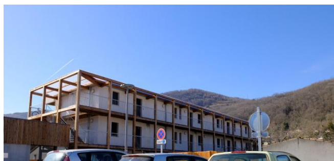
Opération cœur de bourg à Ferrières-sur-Ariège. Source : AUAT
