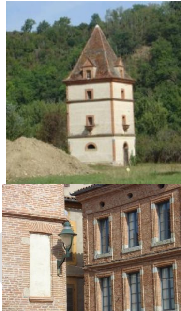
Pigeonnier (Saint-Lieux-Lès-Lavour) - Architecture en briques pour une palette de couleurs chaudes historiques (Lavour)
