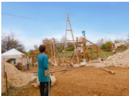
Chantier médiéval de Montcornelles
