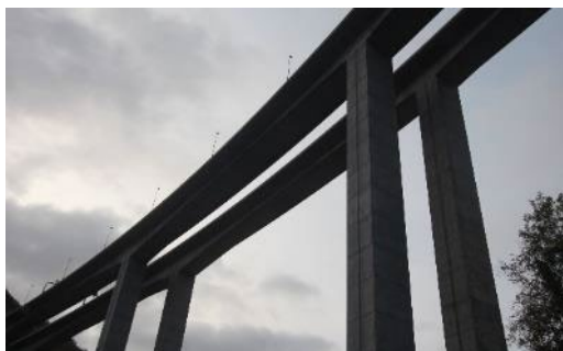
L'autoroute des Titans - Viaduc de Nantua
