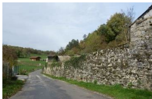
Mur en pierres sèches - Béard- Géovreissiat
