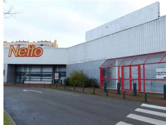
Locaux vacants en zone d'activité, Nogent-le-Rotrou
