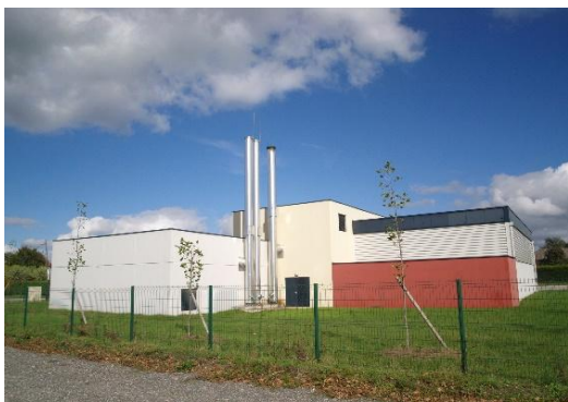
Chaufferie au bois déchiqueté à Montrond-les-Bains
