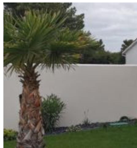
Murs maçonnés (pierres ou enduit)
