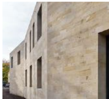
Mur en pierres
