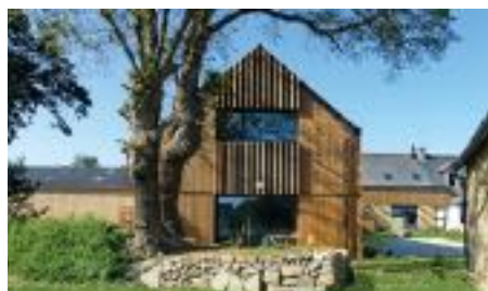
Bardages bois verticaux
