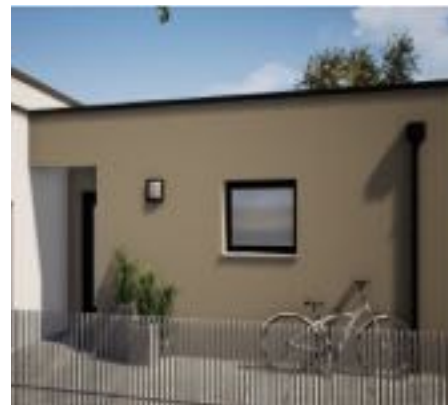
Enduits de façade
