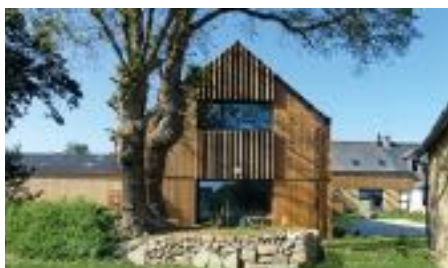
Bardages bois verticaux
